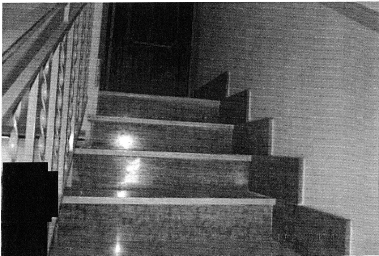
Foto Interna - Scala di accesso al piano 2 – Sub 3
